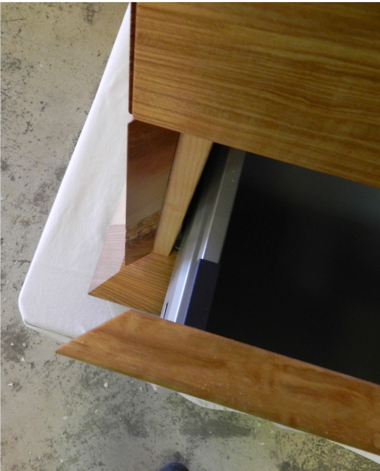
Links: Möbelerückseite. Oben: Gelungenes Detail - Schubladenfront und Seitenwand auf Gerung.
